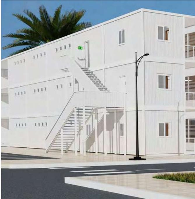
Une construction modulaire est un ensemble d'éléments fabriqués et équipés en usine qui sont ensuite transportés sur site et assemblés entre eux pour former un bâtiment. Les bâtiments modulaires reposent ainsi sur un principe de construction où la majorité des composants sont réalisés en usine.
