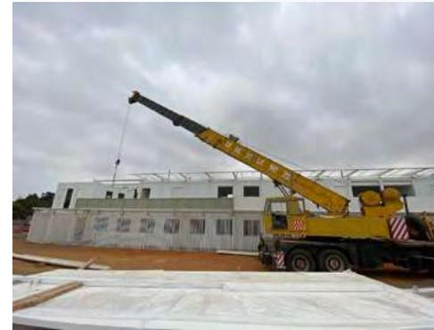
Arrivés sur chantier, les modules ont été assemblés et superposés en étage, parallèlement à la mise en place des installations techniques et des aménagements extérieurs.
